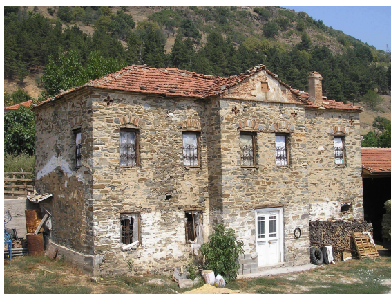
Εικόνα 24. Κατοικία με προεξοχή του κεντρικού χώρου και αέτωμα στον Αετό. (20 ος αι.)
