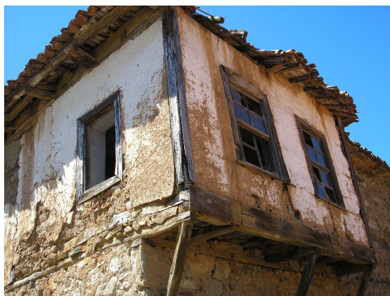
Εικόνα 15. Λεπτομέρεια κατοικίας με σαχνισί στο Σιδηροχώρι
