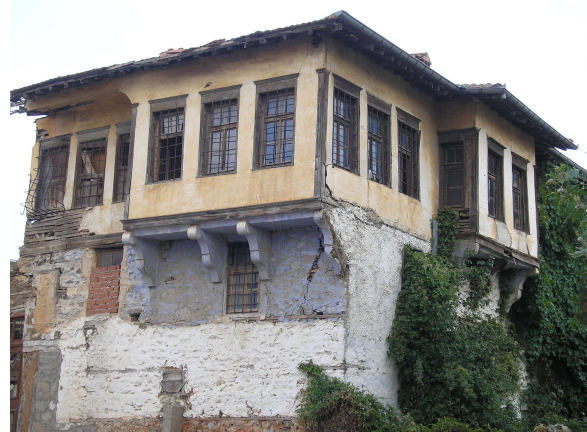
Εικόνα 41. Κατοικία με πέτρινους τοίχους και ξυλόπηκτη κατασκευή στην Κορησό. (19 ος αι.)
