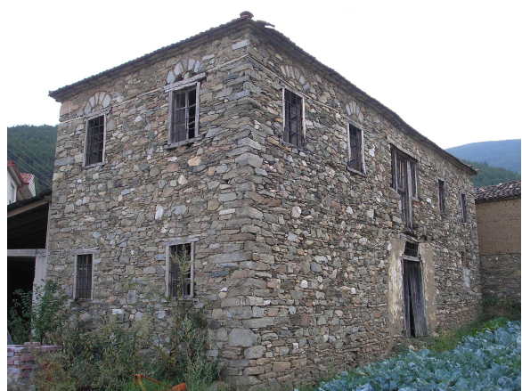
Εικόνα 33. Κατοικία με πέτρινους τοίχους και κρυφές οριζόντιες ξυλοδεσιές στο Βαρίκο. (20 ος αι.)
