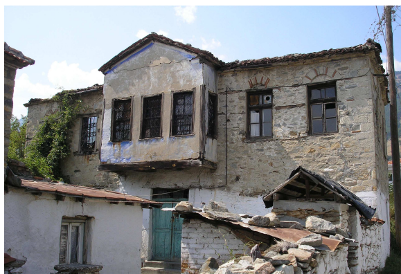
Εικόνα 25. Κατοικία με προεξοχή του κεντρικού χώρου και αέτωμα στο Σκλήθρο. (20 ος αι.)
