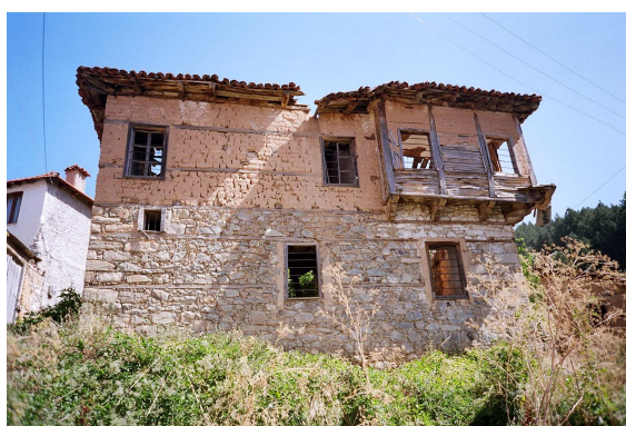
Εικόνα 39. Κατοικία με λιθοδομή και πλινθοδομή στο Ανταρτικό. (19 ος αι.)
