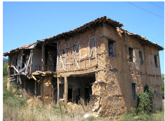
Εικόνα 7. Κατοικία με χαγιάτι στον Γαύρο (19 ος αι.)
