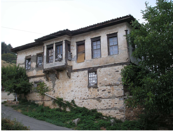
Εικόνα 40. Κατοικία με πέτρινους τοίχους και ξυλόπηκτη κατασκευή στην Κορησό. (19 ος αι.)
