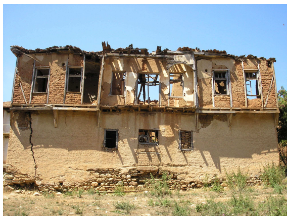
Εικόνα 14. Κατοικία με σαχνισιά στον Κρανιώνα. (19 ος αι.)
