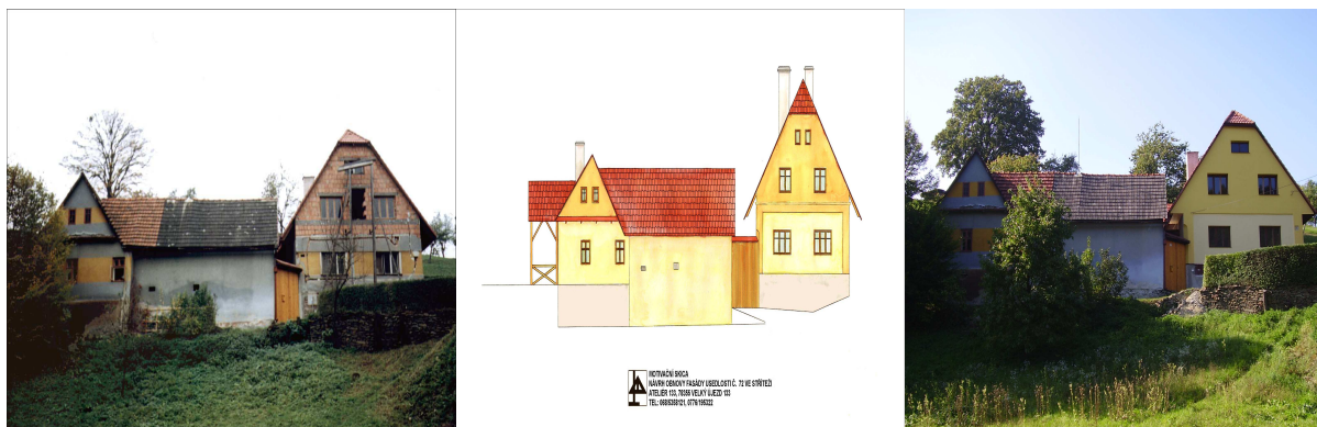
Εικόνα 9. Διατυπώνετε η κατάσταση του κτιρίου πριν την παρέμβαση. Photo 9. Notice the condition of a building prior to the intervention.
