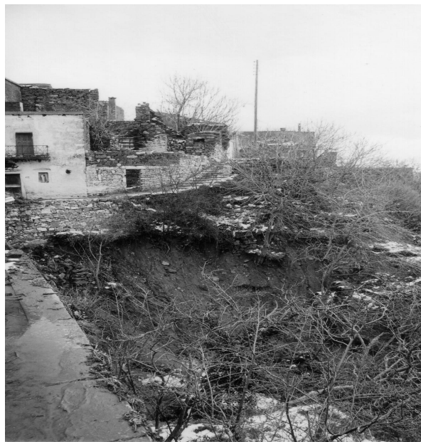
Εικόνα 4. Σκαδό. Κατολίσθηση πλήττει τον οικισμό Figure 4. Skado. Landslide hit the village
