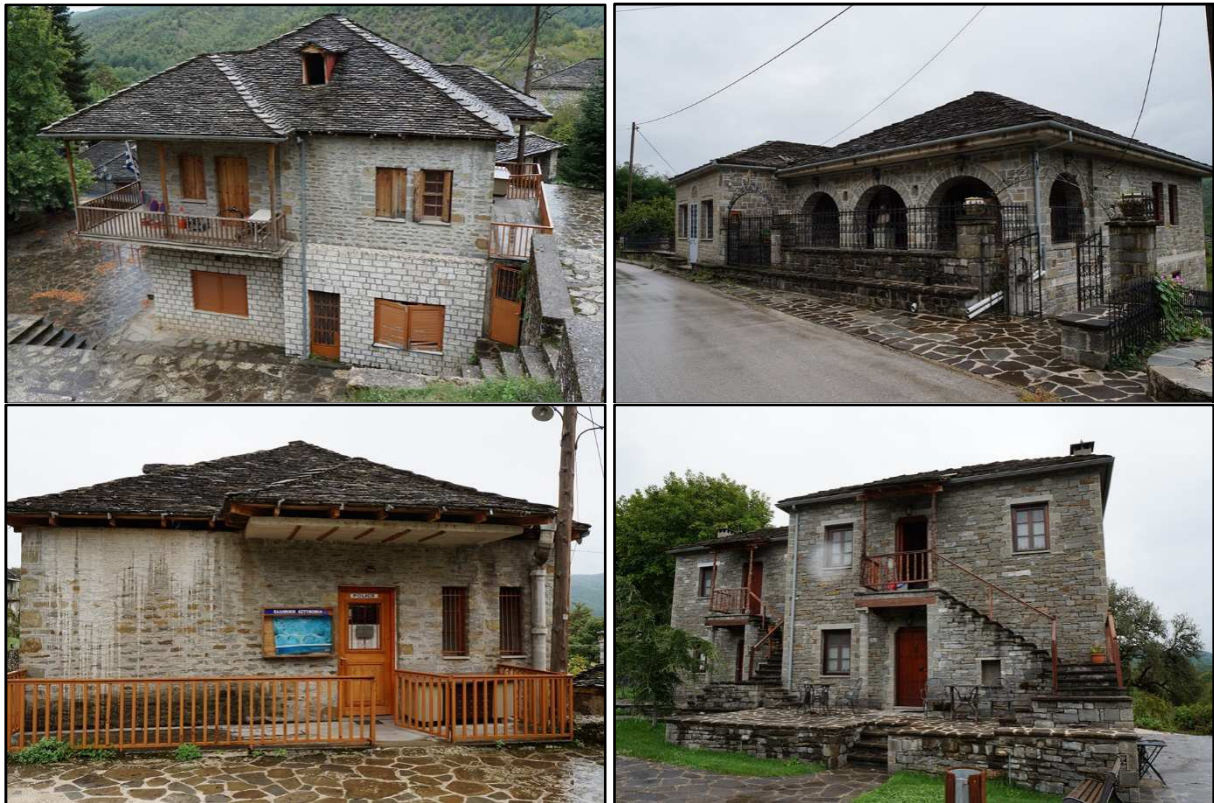
Εικόνες 5-8. Φωτογραφική τεκμηρίωση τυπικών κατοικιών στους Κήπους (ιδία λήψη) Figures 5-8. Photo documentation of typical residencies in Kipoi settlement
