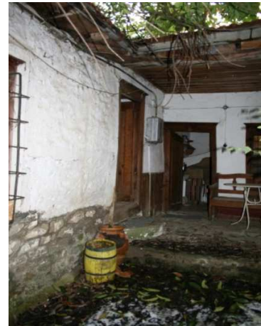
Εικόνα 5. Εσωτερική αυλή Photo 5. Internal yard
