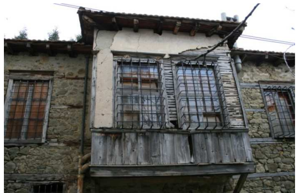
Εικόνα 14. Δυτική όψη- έρκερε Photo 14. West elevation
