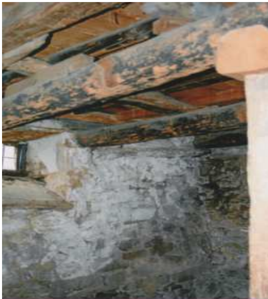
Εικόνα 8. Ξύλινα δοκάρια- υπόγειο Photo 8. Wooden beams- basement
