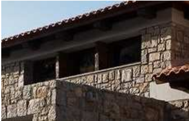
Εικόνα 20. Ανοίγματα και εμφανές μπετονένιο δοκάρι σε πέτρινη όψη Photo 20. Openings and exposed concrete beams in masonry facade
