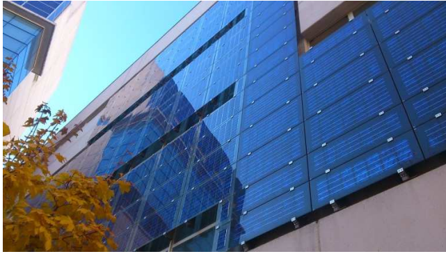
Εικόνα 15. Εφαρμογή φωτοβολταϊκών σε όψη Photo 15. PV panels applied on facade
