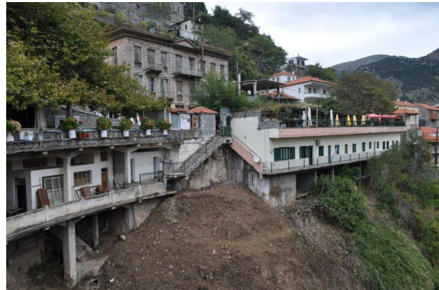
Εικόνες 6,7. Αριστερά: Επέκταση δρόμου πάνω σε πιλοτί, ως πλάτωμα στην εκκλησία Ταξιαρχών. Δεξιά: Η προβληματική υποδομή της κεντρικής πλατείας των Λαγκαδίων. Foto 6,7. Left: Extention of the main road on pilotis, for serving as public space. Right: The doubtful supporting of the central Langadia square.
