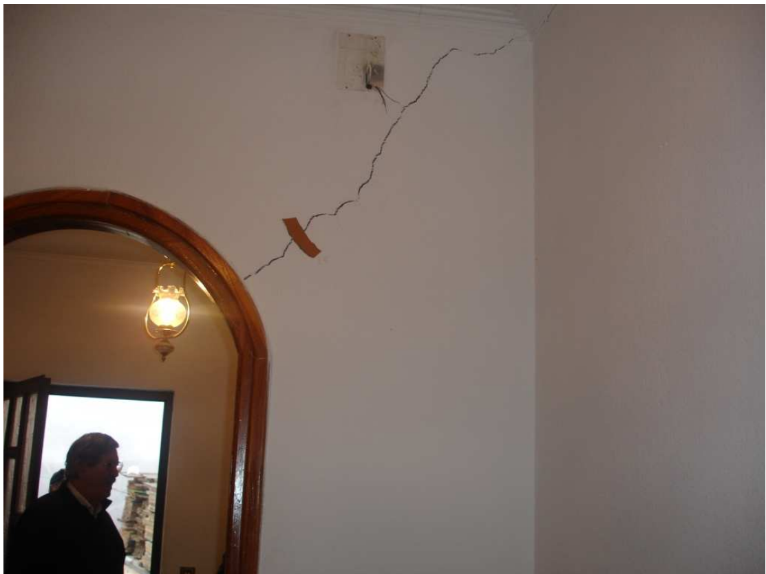
Κατολίσθηση – ερπυσμός περιοχής Αγ. Χαράλαμπου. Παρατηρείται θραύση του οδοστρώματος και ρωγμές στην οικία Πυξομάτη.
