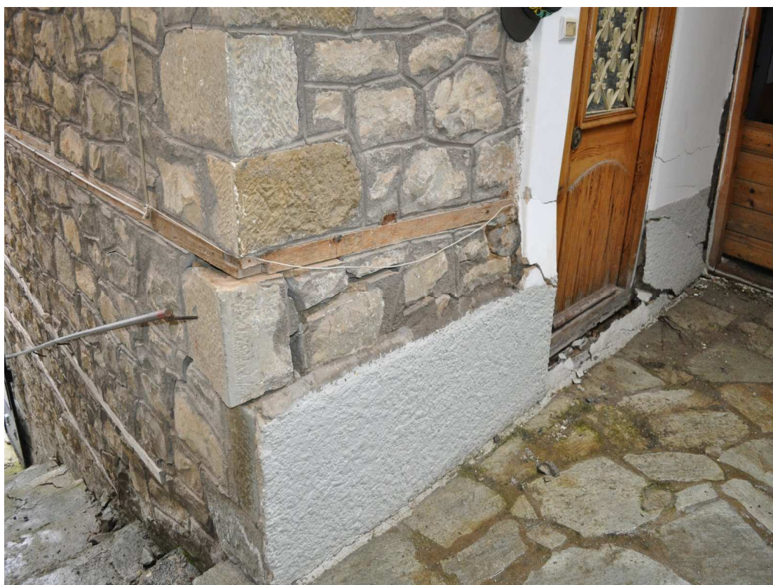
Οικία Σ. Μπάου, 2 ος όροφος. Οι βλάβες είναι σημαντικές και έχει κριθεί ακατοίκητη.
