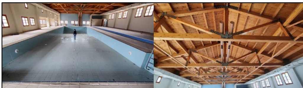
Εικόνα 1. Κολυμβητική δεξαμενή (αρ.) και άποψη της ξύλινης στέγης (δεξ.) (Πηγή: προσωπικό αρχείο)
